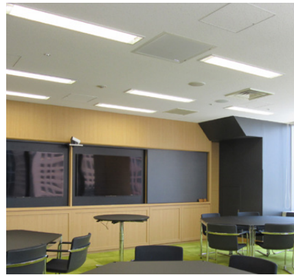
東京校丸の内キャンパスで使用されているシーリングマイクロホン Microflex Advance MXA910。名古屋校丸の内タワーからも遠隔で設定変更などの操作が可能。
