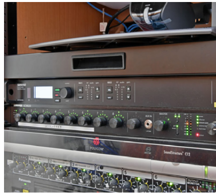
教壇内に設置された ULX-D の受信機 ULXD とオートマッチックミキサー SCM820。現在は 8ch で使用している。
