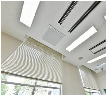
空調機の側に設置された MXA910。MXA910 はホワイト、ブラック、アルミの3色。塗装も可能。
